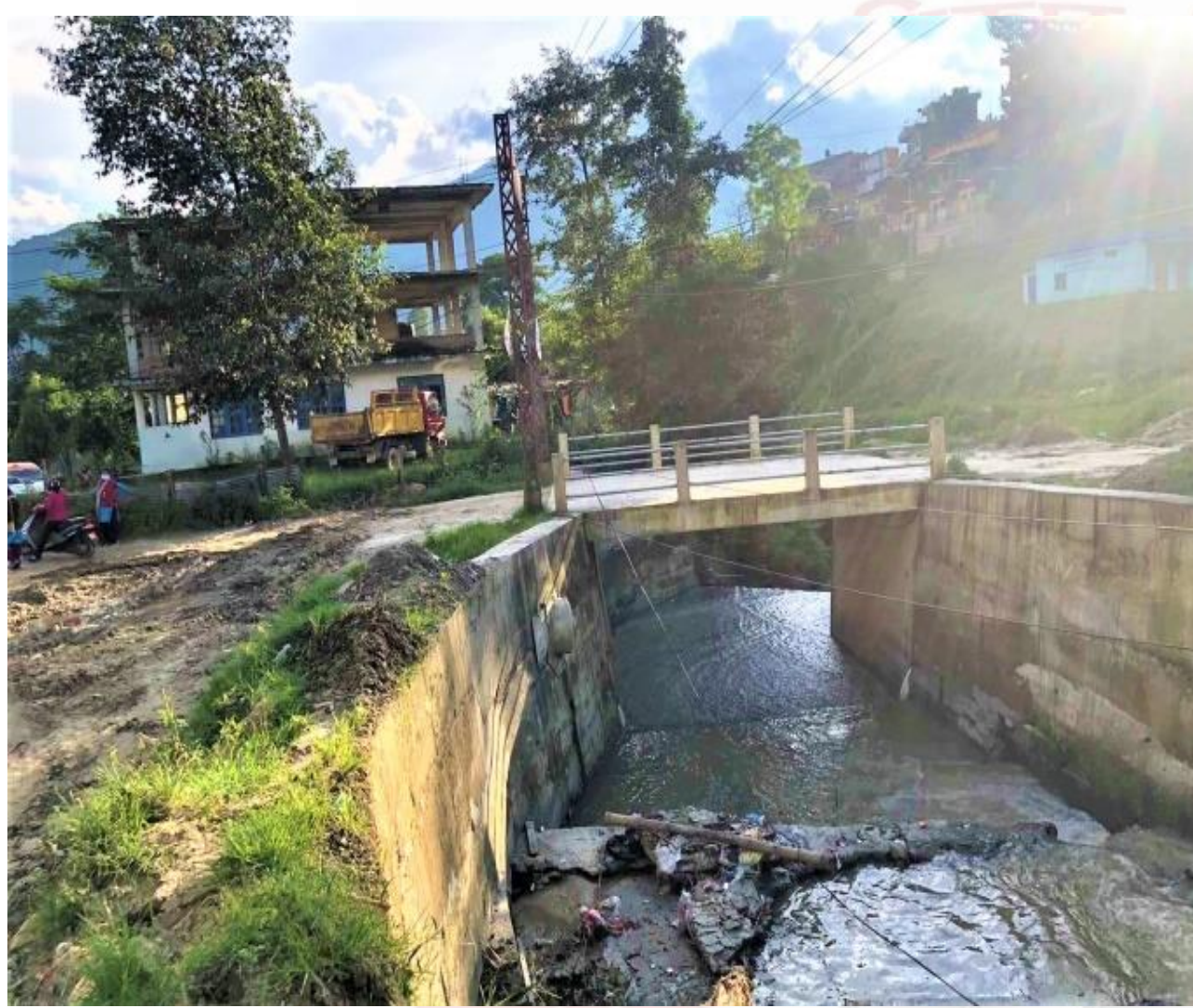
धर्मस्थली पृकुन स्थित कल्भर्ट र पछ्छाडि देखिएको नवनिर्मित प्रहरी चौकी भवन
