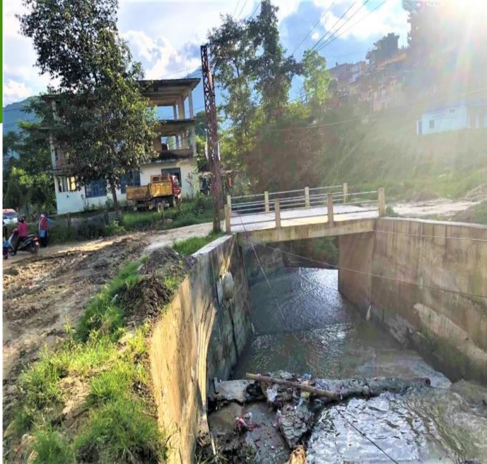
धर्मस्थली पृकुन स्थित कल्भर्ट र पछाडि देखिएको नवनिर्मित प्रहरी चौकी भवन
