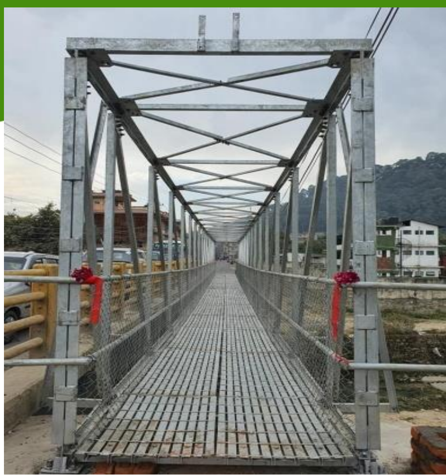
बहदो शहरीकरणलाई मध्यनजर गर्दै पैदल यात्रु आवात जावात गर्न बनाईएको नेपालटार पुलसँगै निर्मित Pedestrian Steel Bridge
